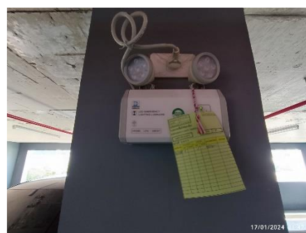
ภาพที่ 2.2-28 ระบบไฟฟ้าสำรอง ไฟฉุกเฉินภายในโครงการ
